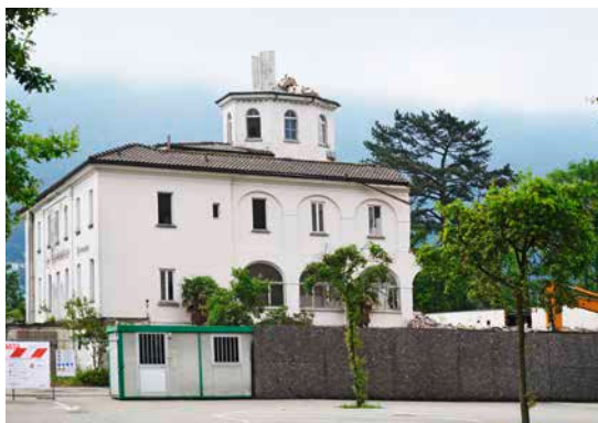
I lavori di demolizione di Villa Galli («La Romantica») a Melide, giugno 2013 (foto Natalie Danzi-Paces)
