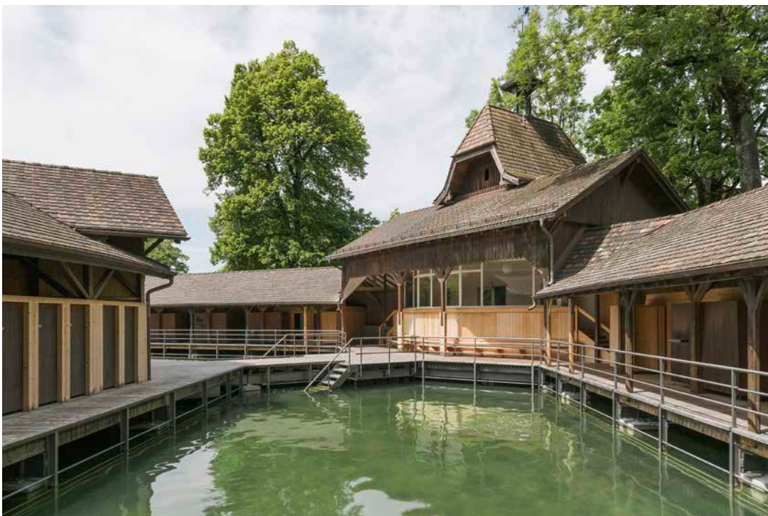
Il «Frauenbad», riservato alle donne, fu realizzato tra il 1896 e il 1897 nel Kreuzweiher, uno dei tre piccoli laghi artificiali creati nel XVII secolo a San Gallo a scopo di approvvigionamento idrico; la struttura è stata restaurata nel 2020 (foto Tanja Schätti / Patrimonio svizzero)
