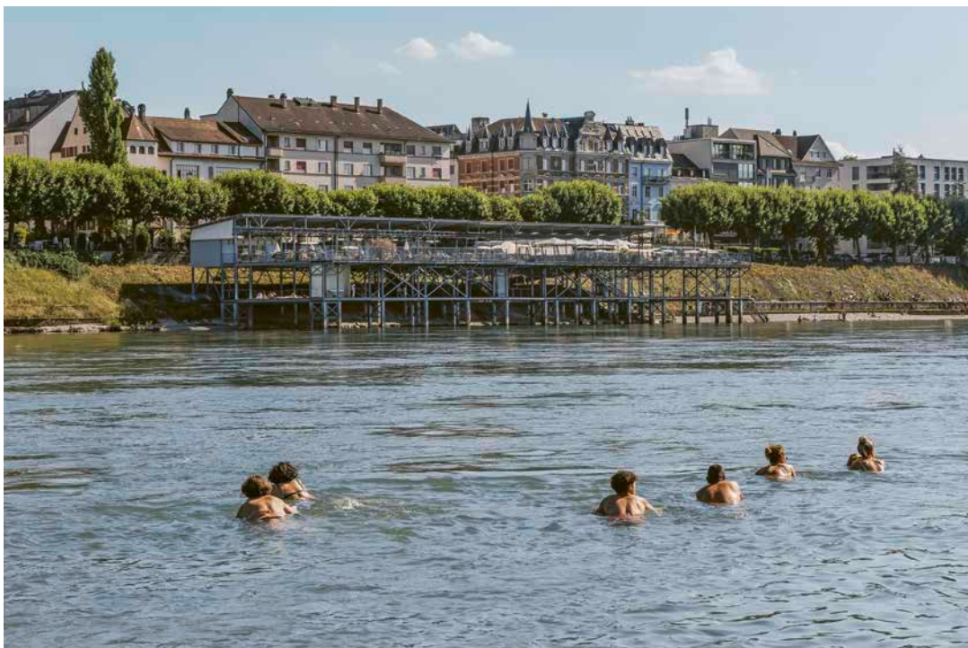
Il «Rheinbad Breide» a Basilea, costruito nel 1898, ampliato nel 1929 e poi parzialmente dismesso, è tornato in voga alla fine degli anni Novanta, quando la qualità dell'acqua del Reno è migliorata; è stato infine restaurato e ampliato tra il 2019 e il 2023 nel rispetto della sua sostanza storica (foto Tanja Schätti / Patrimonio svizzero)
