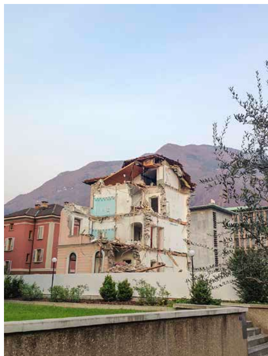
La demolizione del Villino Salvioni a Bellinzona, nell'aprile del 2013
